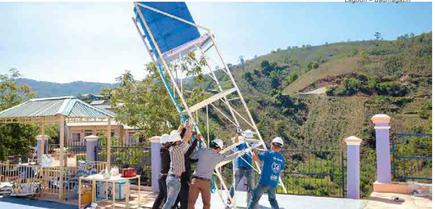
Das Team beim Errichten eines AquaTowers in Vietnam. Der Turm liefert gefiltertes, sauberes Wasser.
