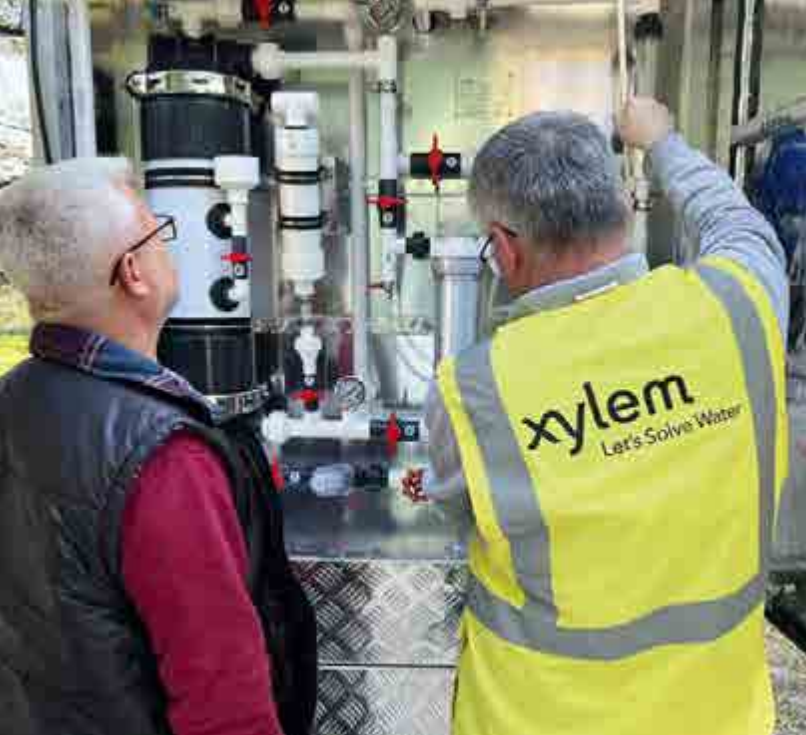
Oben: Sieht kompliziert aus – ist es auch. Zum Glück gibt es Xylem. Unten: Hygieneregeln können Menschenleben retten und werden hier deshalb mitgelehrt.
