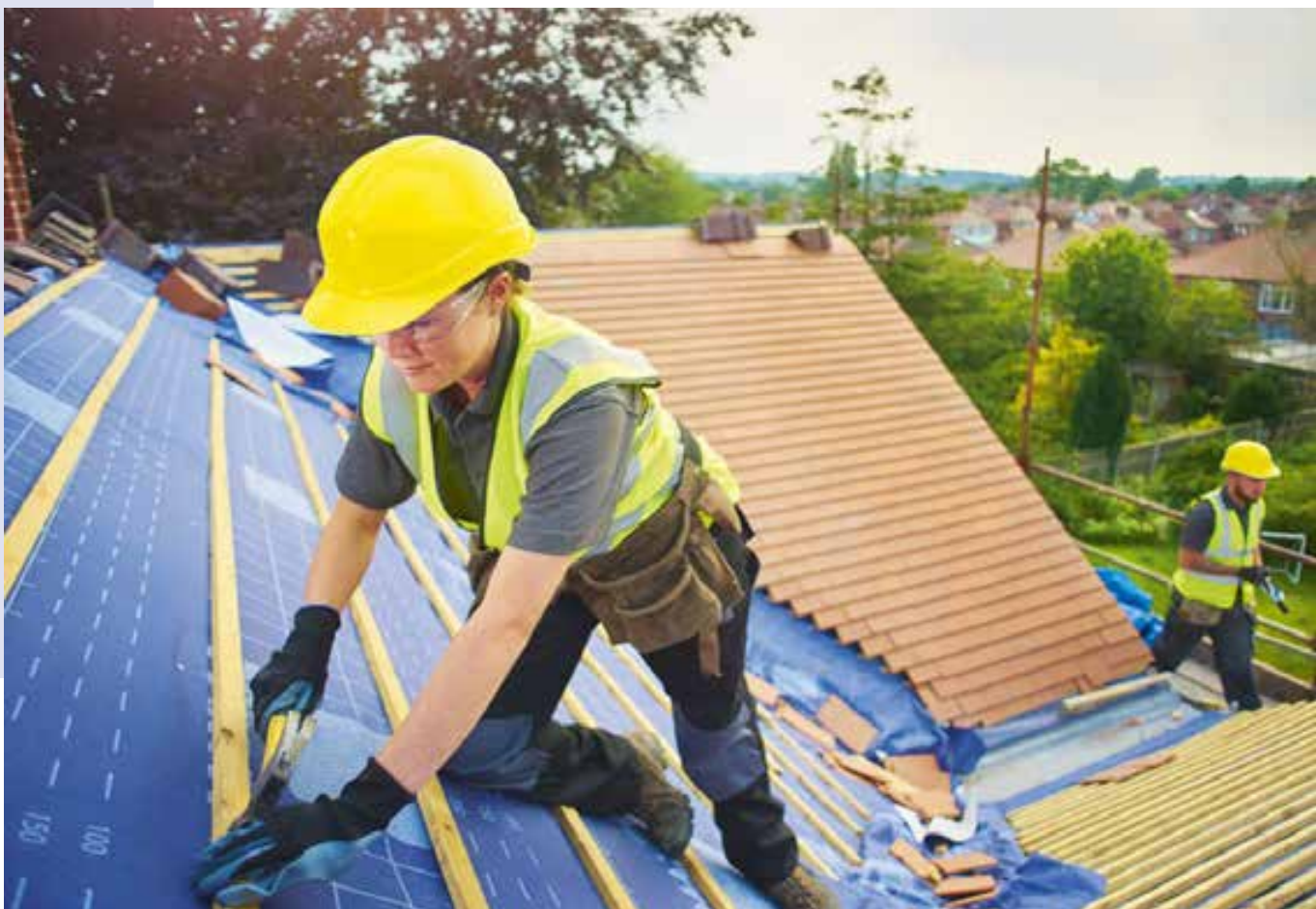
Oben: Solarpaneele fangen die Energie der Sonne ein. Unten: Unter der Lattung die richtige Unterspannbahn, um Schnee, Regen und Staub draußen zu halten.
